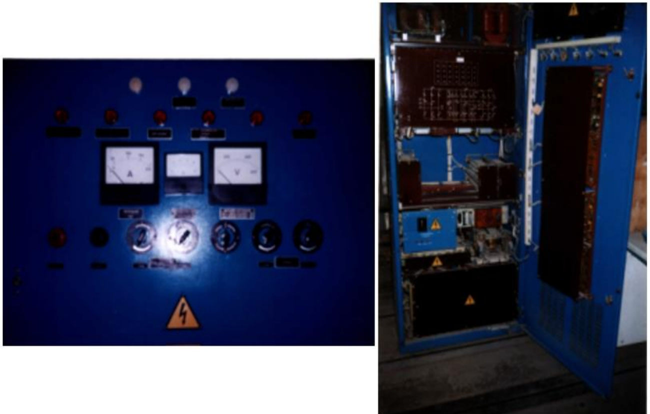
Рисунок 5.10 — Приборная часть и общий вид электропривода
