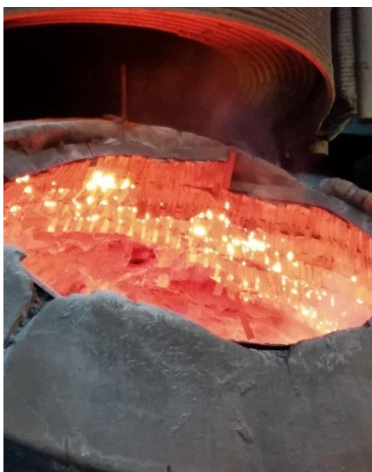
Рисунок 5 — Состояние отремонтированной футеровки после разогрева
