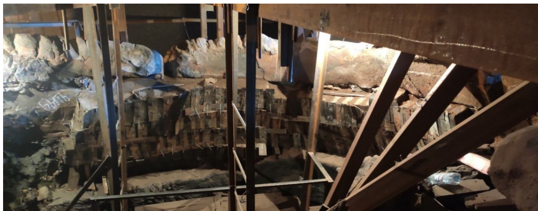
Рисунок 4 — Работы по восстановлению кладки футеровки
