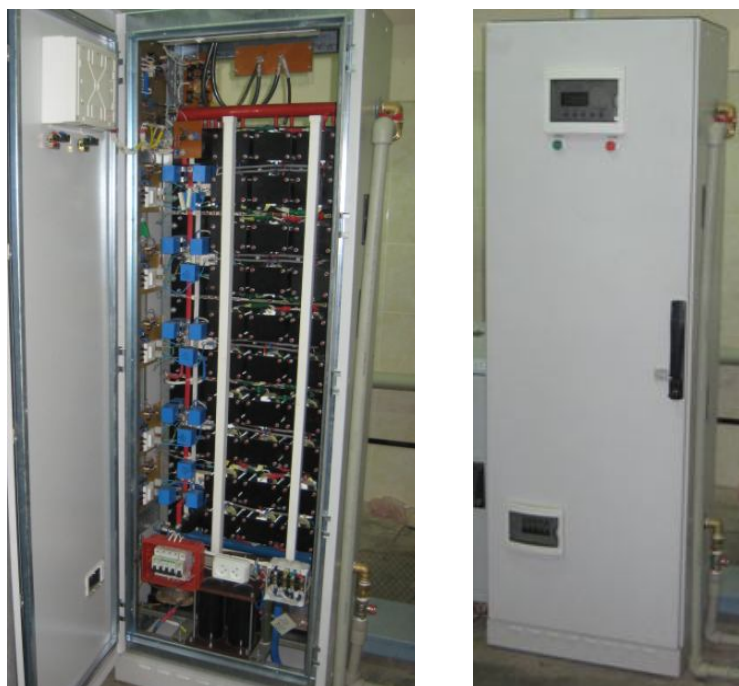
Рисунок 1 — Общий вид высоковольтного источника питания ВИП-2-15: а — общий вид функциональных узлов ВИП, при открытой двери; б — общий вид с системами ручного управления и подключенными коммуникациями
